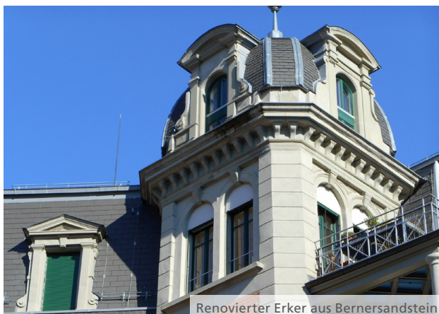
Renovierter Erker aus Bernersandstein
